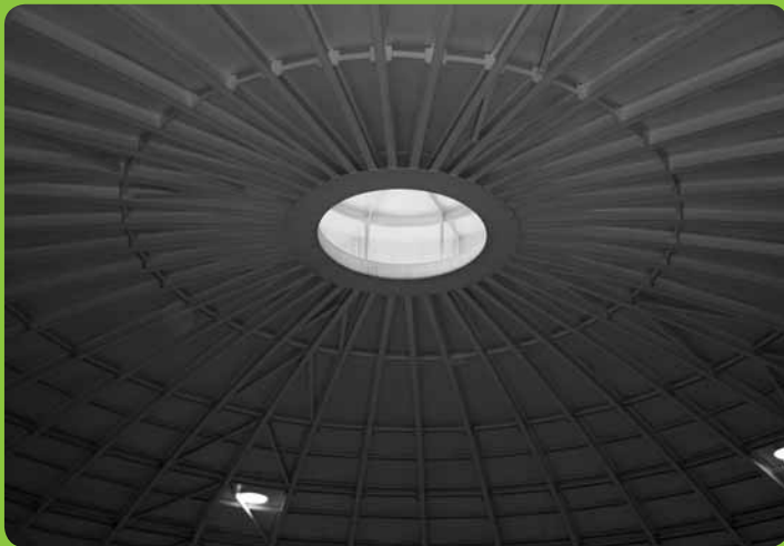
Tornion häkäkaasusäiliö sisältä.
